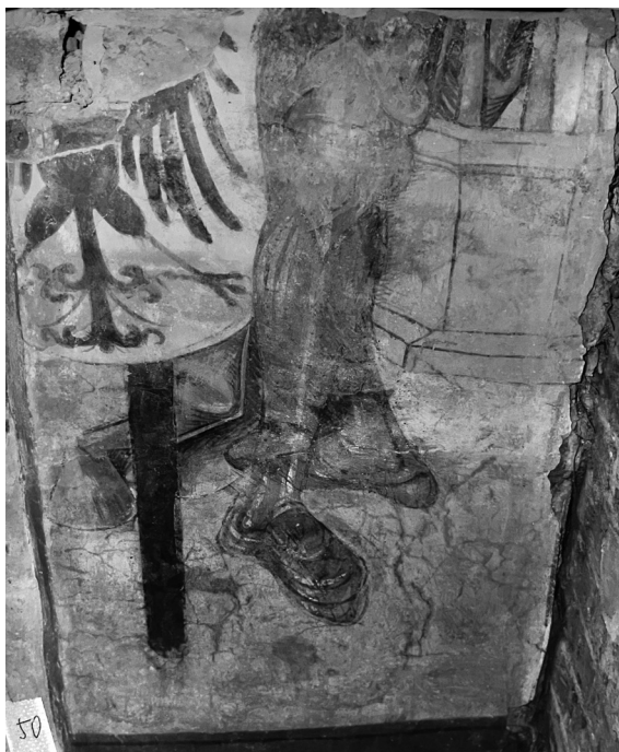
13. Warsztat wrocławski, Św. Wacław (?), fragment malowideł ściennych w kościele św. Katarzyny we Wrocławiu, ok. 1500–1515. Fot. Pracownie Konserwacji Zabytków, Wrocław, dokumentacja stanu z 1975 roku Wrocław workshop, St. Wenceslaus (?), fragment of wall paintings in St. Catherine's Church in Wrocław, ca. 1500–1515. Photo: Monument Conservation Workshops, Wrocław, condition report from 1975
