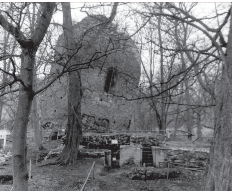
Abb. 5: Burgruine Galenbeck (Besonderer Augenmerk lag hier auf den bei einer Belagerung stark beschädigten Turm) (Foto: Michas/Gransow).
