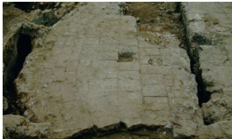
Abb. 10: Brennraumboden eines Steinzeug-Brennofens des 19. Jahrhunderts, belegt mit Tonplatten; Frechen Hochstedenstraße.
