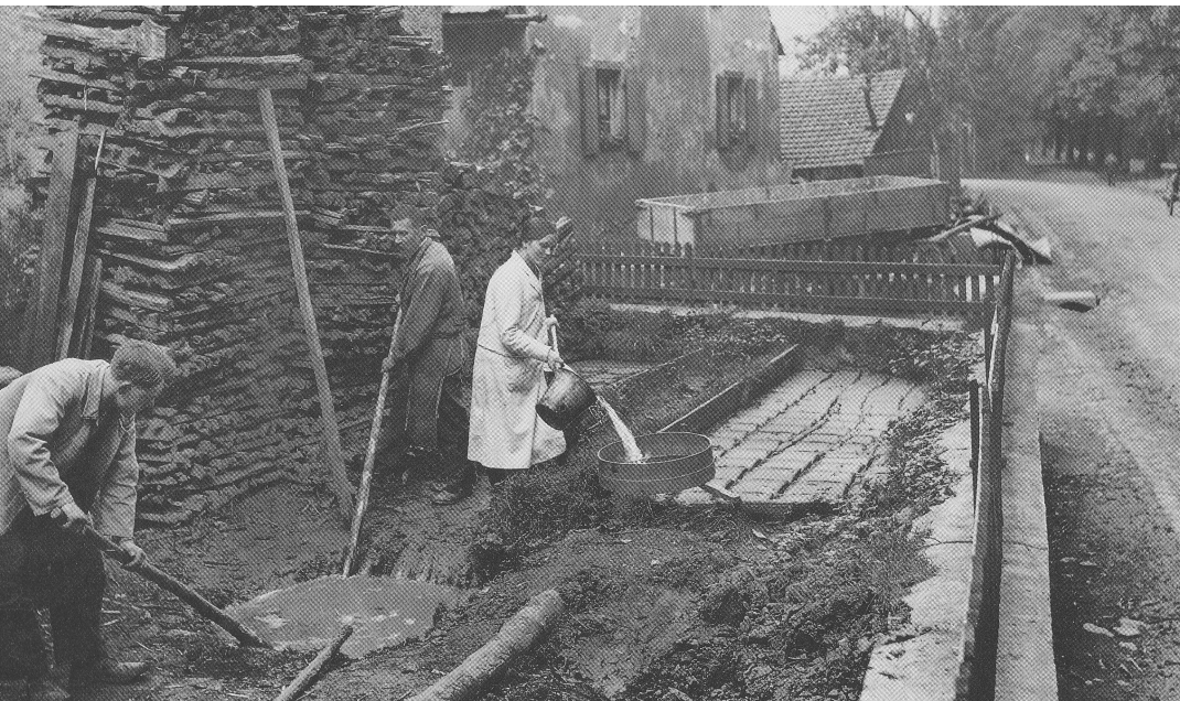
5 Der Hafnermeister Josef Maier, seine Tochter Emma und ein Gehilfe beim Schlämen von Ton auf dem Grundstück hinter der Hafnerei Maier in Staufen. Im Hintergrund an der Hauswand ist Brennholz für den Brand gestapelt, rechts befindet sich das Schwämmebeet, in Quadrate eingeteilt (Fotografie Kuban, 1925. BLM Außenstelle Staufen, Sammlung Maier/Bregger, Inv. Nr. BA 2005/747).
