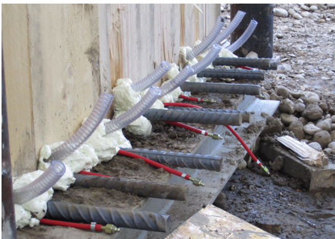
9 Armierungseisen und durch die Bohrungen gezogene Schläuche vor dem Einpressen des Kunstharzes (Foto: Norbert Spichtig, ABBS).
