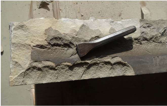
2 (links) Setz- oder Bossiereisen. Rechts daneben befindet sich ein aus zwei parallelen Strichen bestehendes altes Versetzzeichen (Foto: Heiko Steinwand).
