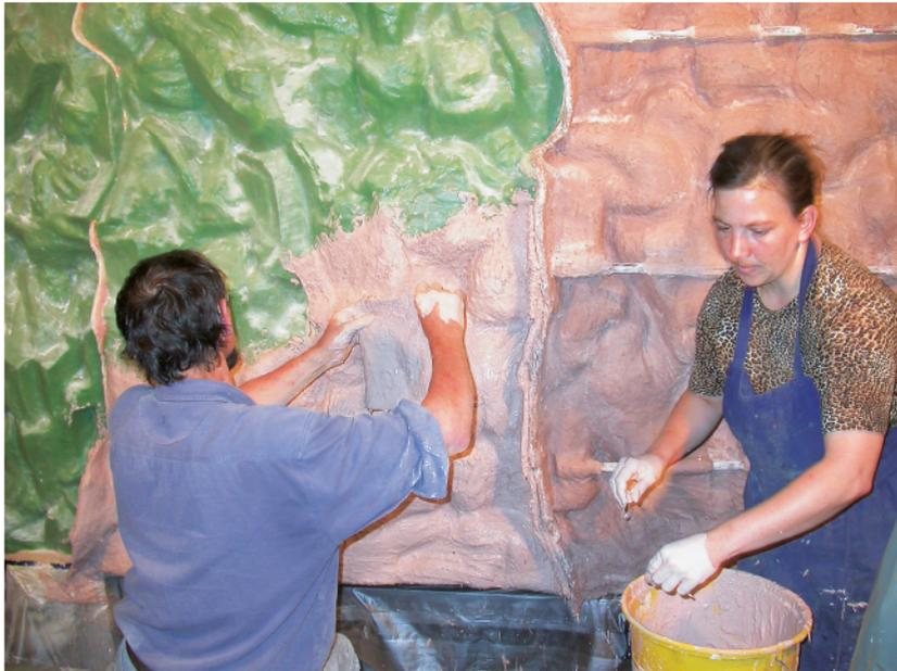
**Abb. 10** Aufbringen der Stützkapsel mit Formenbaugips.
