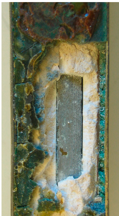
Abb. 12 Materialien der Beinkerne der Erstrestaurierung von 1895-1900.
