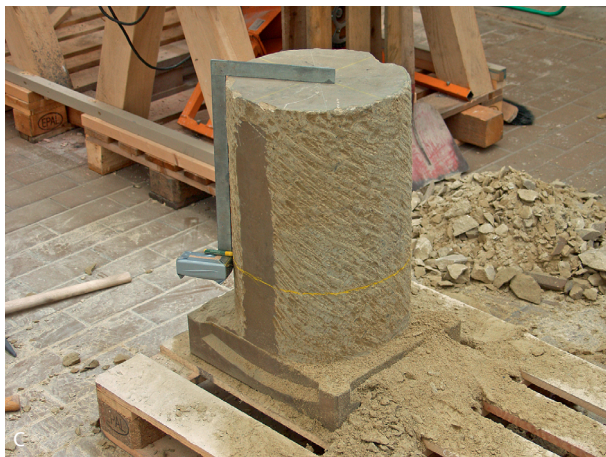
Abb. 21 a-d Zurichtung eines Rohblockes für eine Säulenbasis (Fotos Th. Flügen, Archäologisches Museum Frankfurt).
