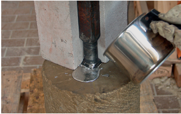
Abb. 22 Das Einbleien der Eisenwellen (Foto Th. Flügen, Archäologisches Museum Frankfurt).
