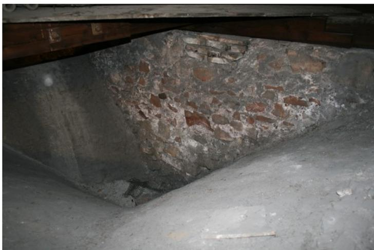
14 Ritterkapelle, Mauerkrone aus Zwickelmauerwerk. Die Steine wurden wiederverwendet und zeigen Brandspuren.
