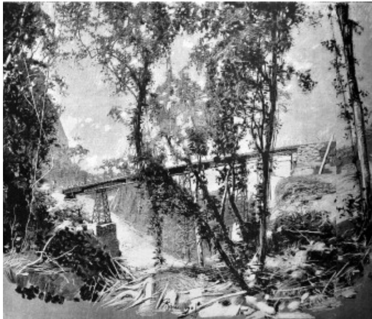
9 BRASIL. - Viaduto da Grota Funda, na estrada de ferro do Príncipe do Grão Pará, serra da Estrela. - Desenho de A. Ramalho. (BRAZIL. - Grota Funda Viaduct, on Prince of Grão Pará railway, seta da Estrela. - Drawing by A. Ramalho.) Engraving from: A Ilustração , 20 February 1885, 60. Lisbon, Museu Bordalo Pinheiro, Library
