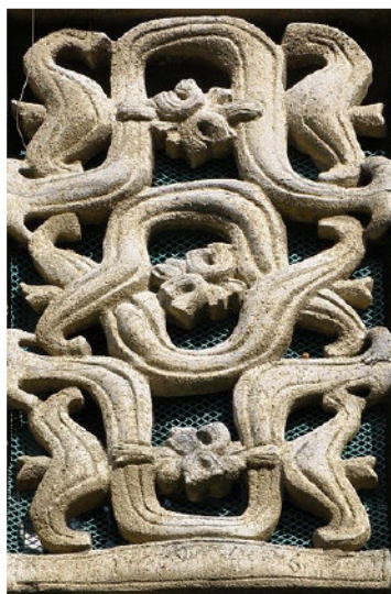
3 Jerzy Jarnuszkiewicz & Bohdan Lachert, krata z gruzobetonu przy ul. Katowickiej 8 a w Warszawie, 1946. Fotografia własna autorki
