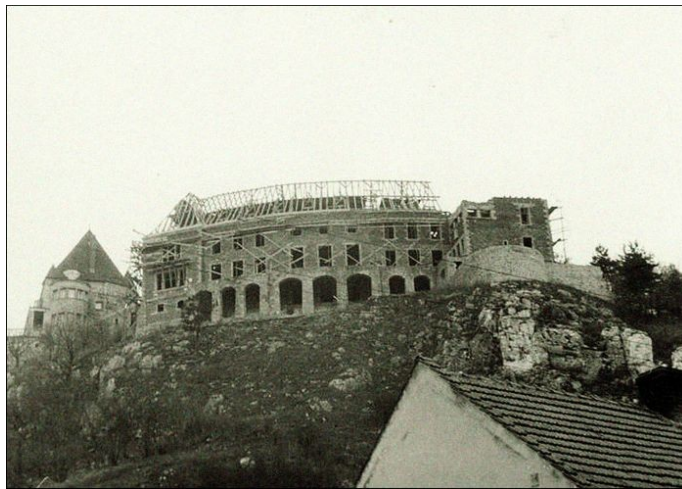
16 Construction of Schloss Wartenberg in the Przegorzały suburb of Cracow, 1942, photo: Ewald Theuergarten. National Digital Archives (Narodowe Archiwum Cyfrowe), Warsaw, file no. 2-8646a
