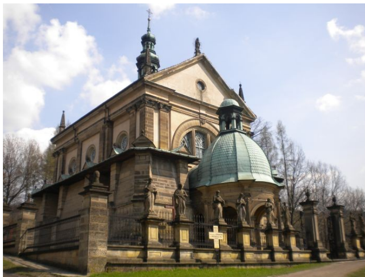
16 Kościół pw. Wniebowzięcia NMP w Brodach (Kalwarii Zebrzydowskiej), 1611–1615, 1623–1630 (fot. Marek Świdrak)
