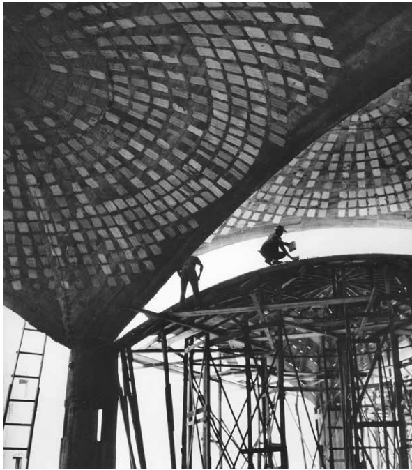
19 Cantiere dello stabilimento Olivetti di Guarulhos con le volte in laterizi in costruzione, 1958. Ivrea, AASO, Fondo Lodovichi Architettura varia (13), fasc.162 (foto AASO)
