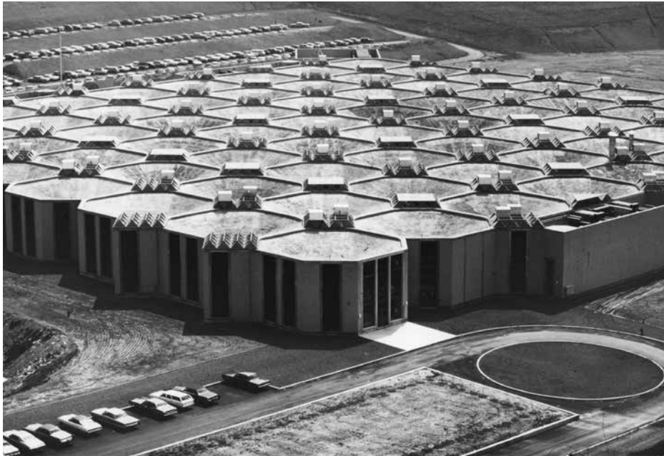
32 Veduta aerea dello stabilimento Olivetti-Underwood (progetto di Louis Isadore Kahn), Harrisburg Penn. (USA), 1970. Ivrea, AASO, Fondo Stabilimenti consociate (6), fasc. 87 (foto AASO)
