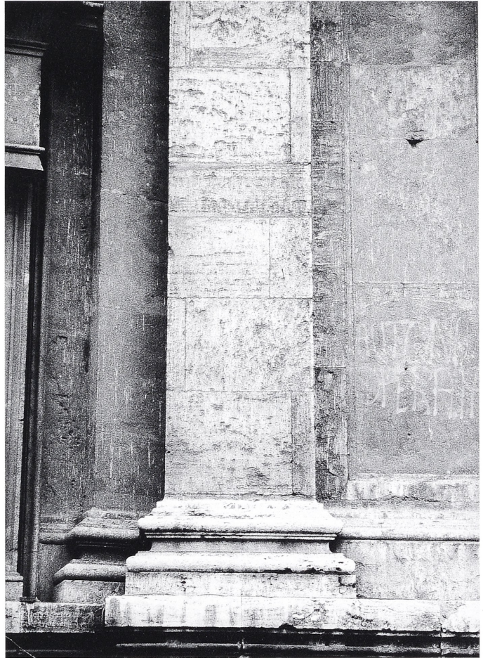
40. Rom, Sant'Agnese, Steinversetzung an einem der äußeren, unter Carlo Rainaldi errichteten Pilasterpaare
