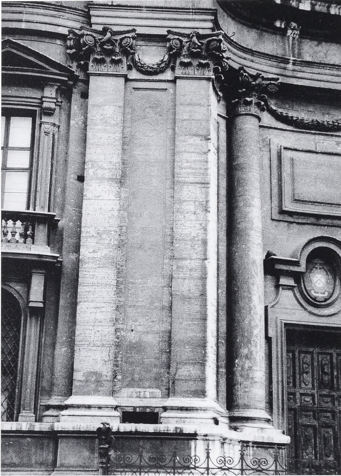
29. Sant'Agnese, Pilasterpaar mit Spuren der ursprünglichen Reliefdekoration
