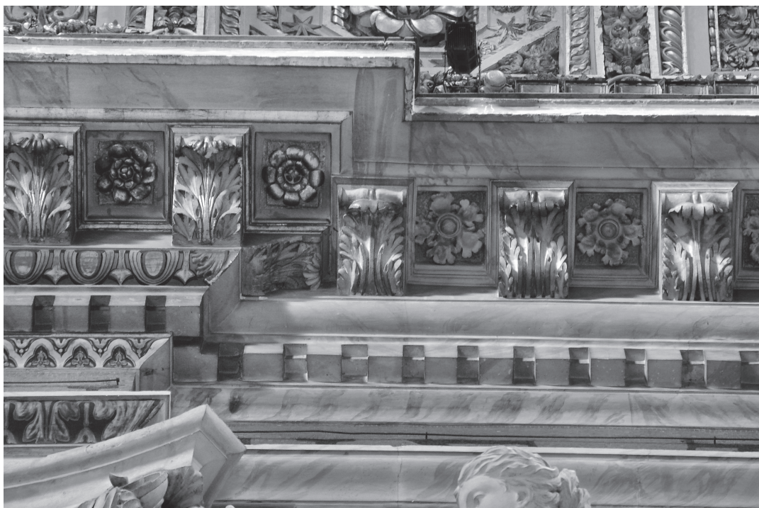
23. St. Peter, Nordwand des Chorarms, Gebälk. Links der erste (östliche) Pilaster des Konterpfeilers mit dem Gebälk Della Portas, rechts das Gebälk Bramantes (Foto H. Schlimme)
