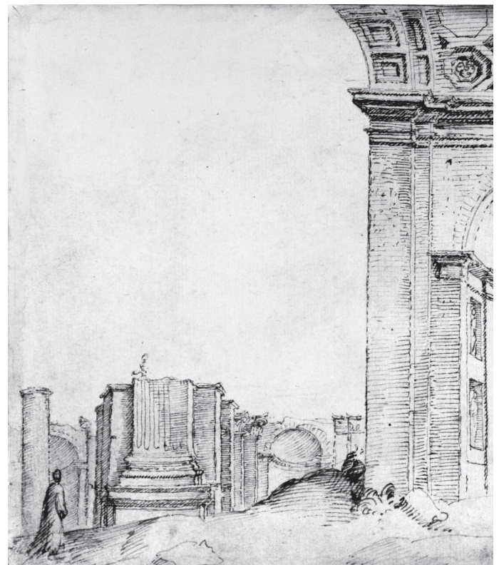
7. Maerten van Heemskerck, Südtribuna von St. Peter, Zustand 1532/36, Ausschnitt. Links der östliche Pilasterpfeiler der Apsis, dahinter die Innenwand des dann von Michelangelo abgebrochenen Umgangs, rechts der westliche Konterpfeiler (vgl. die erläuternde Skizze bei WOLFF METTERNICH/THOENES 1987, Abb.196). Berlin, SMPK, Kupferstichkabinett, Heemskerck-Alben, 1, fol.8r (Foto Bibliotheca Hertziana, Rom)
