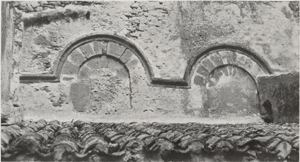
Abb. 63. Cefalù, Dom. Vermauerte Fenster des rechten Seitenschiffes
