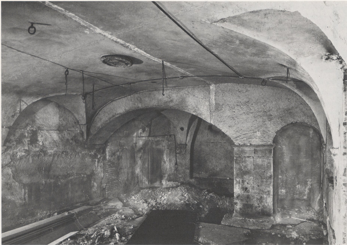
8. Palazzo Venezia, Kellergeschoß raum Nr. 7 des Kardinalspalastes mit späterer Stützmauer für die Osttreppe
