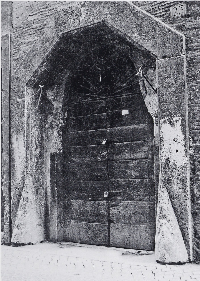
22. Rom, Hofeinfahrt des Hauses Via dei Funari Nr. 23
