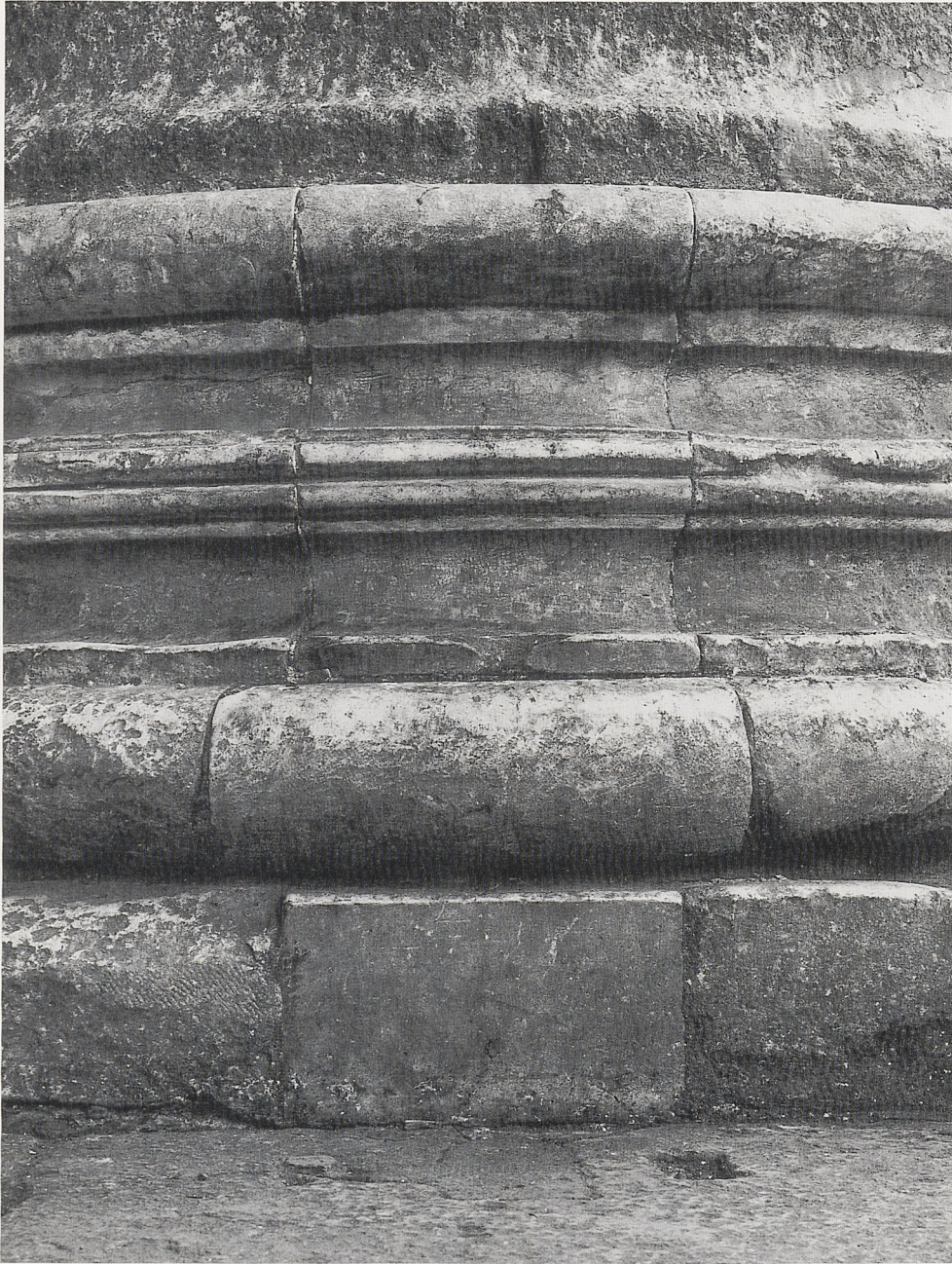
4. Rom, Pantheon. Reparierte Säulenbasis (wie Abb. 3 vorn)
