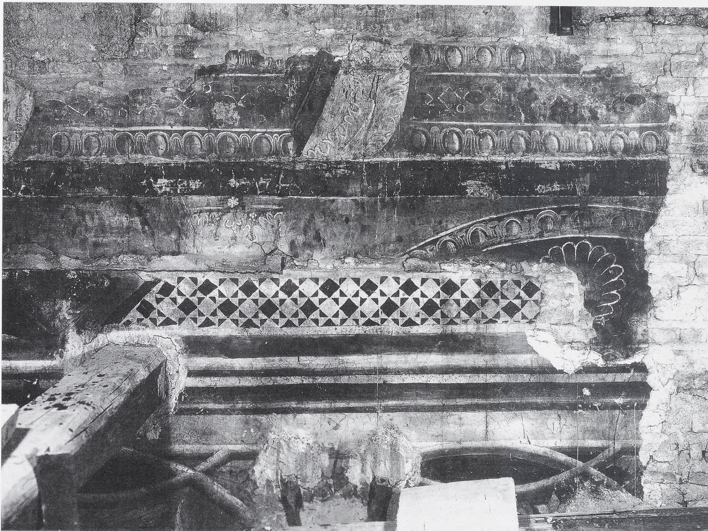
13. Città del Vaticano, Palazzo Apostolico Vaticano, Segreteria di Stato, intercapedine della Sala dei Chiaroscuri, particolare della parete est
