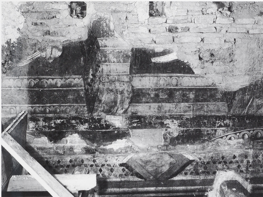
12. Città del Vaticano, Palazzo Apostolico Vaticano, Segreteria di Stato, intercapedine della Sala dei Chiaroscuri, particolare della parete est
