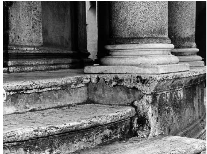
6 Rom, San Pietro in Montorio, Tempietto, Nachträglicher Einbau von begehbaren Stufen in den überhöhten Stylobatsockel an den beiden Seiteneingängen (Foto Bibliotheca Hertziana)
