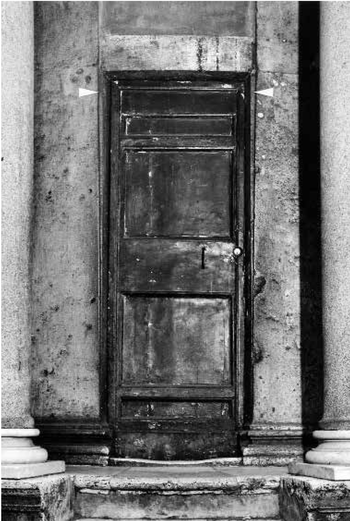
5 Rom, San Pietro in Montorio, Tempietto, Seitentüre, Pfeile: Sturzaufleger in konstruktiver Verbindung mit Pilaster (Foto Bibliotheca Hertziana)
