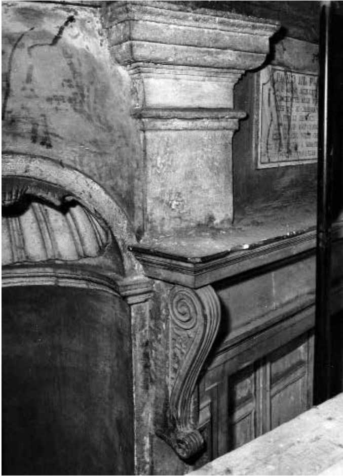
7 Rom, San Pietro in Montorio, Tempietto, Anschluss des ionischen Türgebälks und der Stützvolute an die Cellapilaster (Foto Bibliotheca Hertziana)
