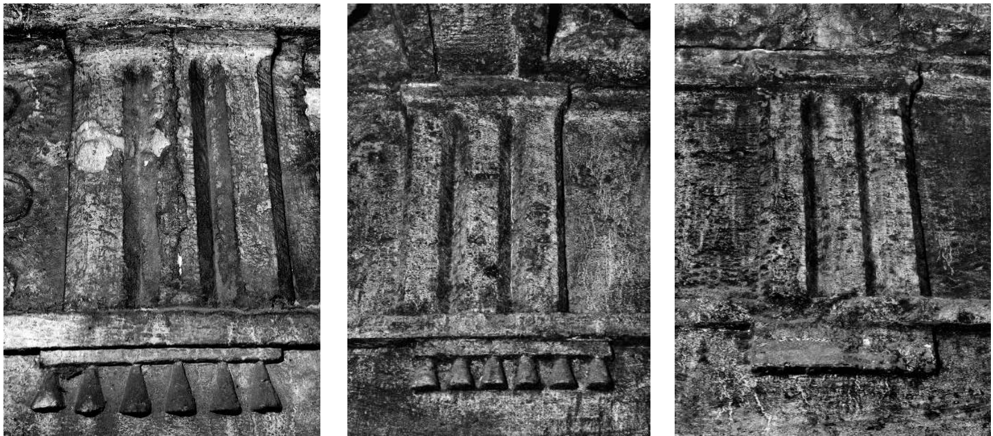
10 Rom, San Pietro in Montorio, Tempietto, Details der Triglyphen und der Regulae (Foto Bibliotheca Hertziana)
