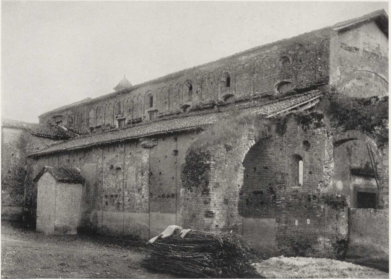
Abb. 153. Lomello, S. Maria Maggiore. Außenbau von Nordwesten
