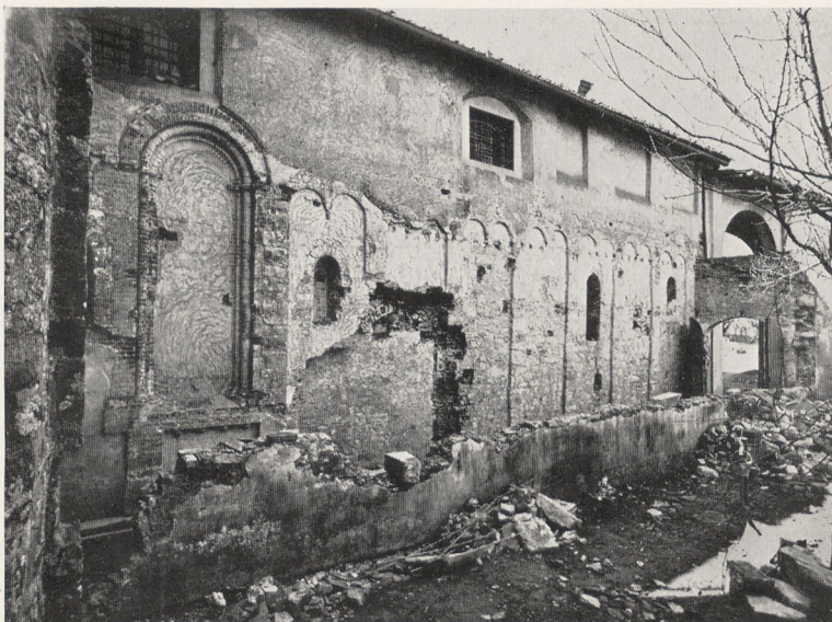
Abb. 147. Settimo, Abteikirche. Nördliche Seitenschiffswand
