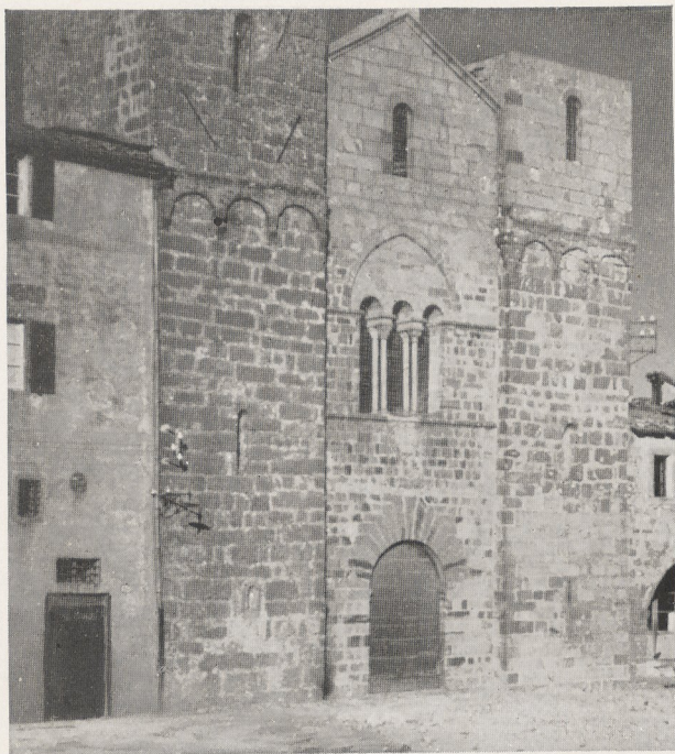
Abb. 196. Abbazia S. Salvatore, Klosterkirche. Westfassade
