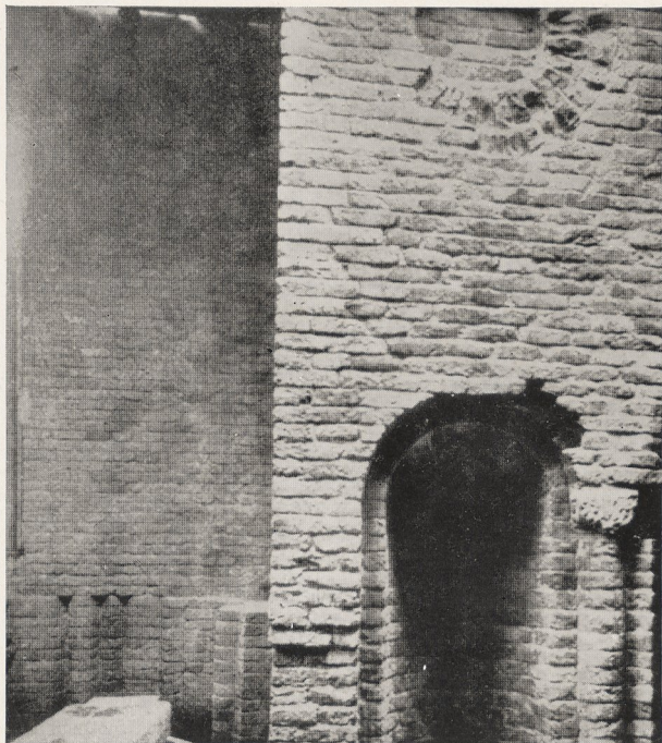
Abb. 176. Venedig, S. Marco. Mauerdetail vom Außenbau vor der Marmorverkleidung (nach Marangoni)
