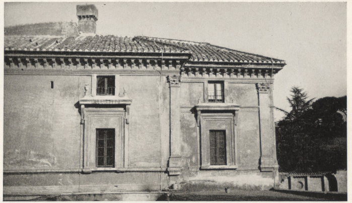
15. Villa Giulia, Detail der Südseite
