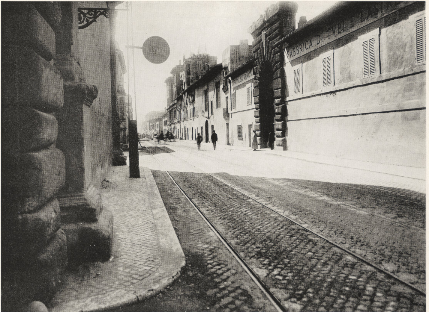
12. Via Flaminia, Haus und Eingangstor der Vigna del Porto, vor dem Abbruch
