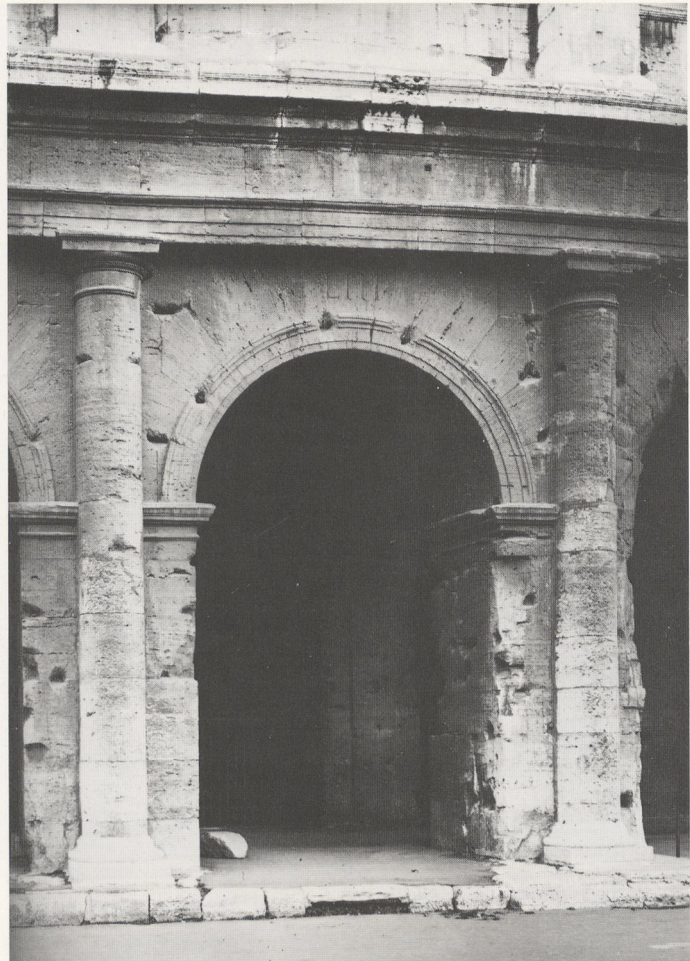
32. Rom, Kolosseum, Außenbau, Detail
