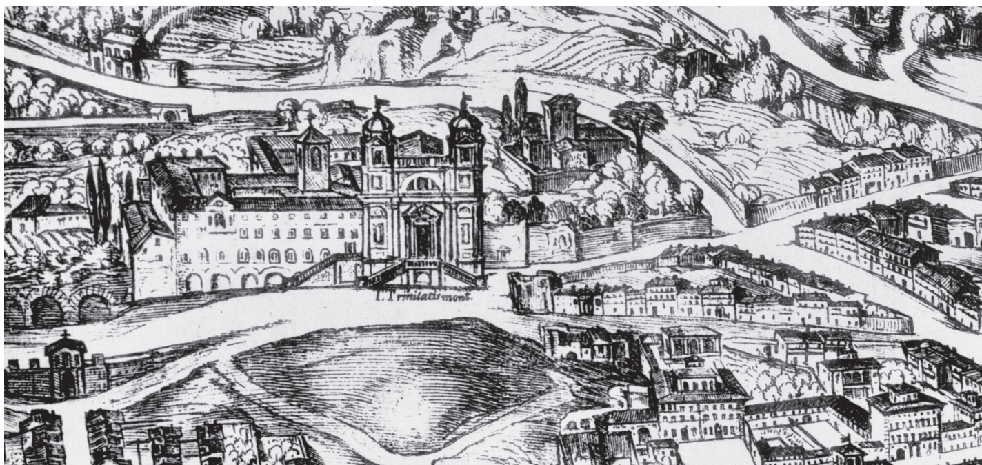
3. Antonio Tempesta, Pianta di Roma (particolare di palazzo Zuccari in costruzione, 1593)
