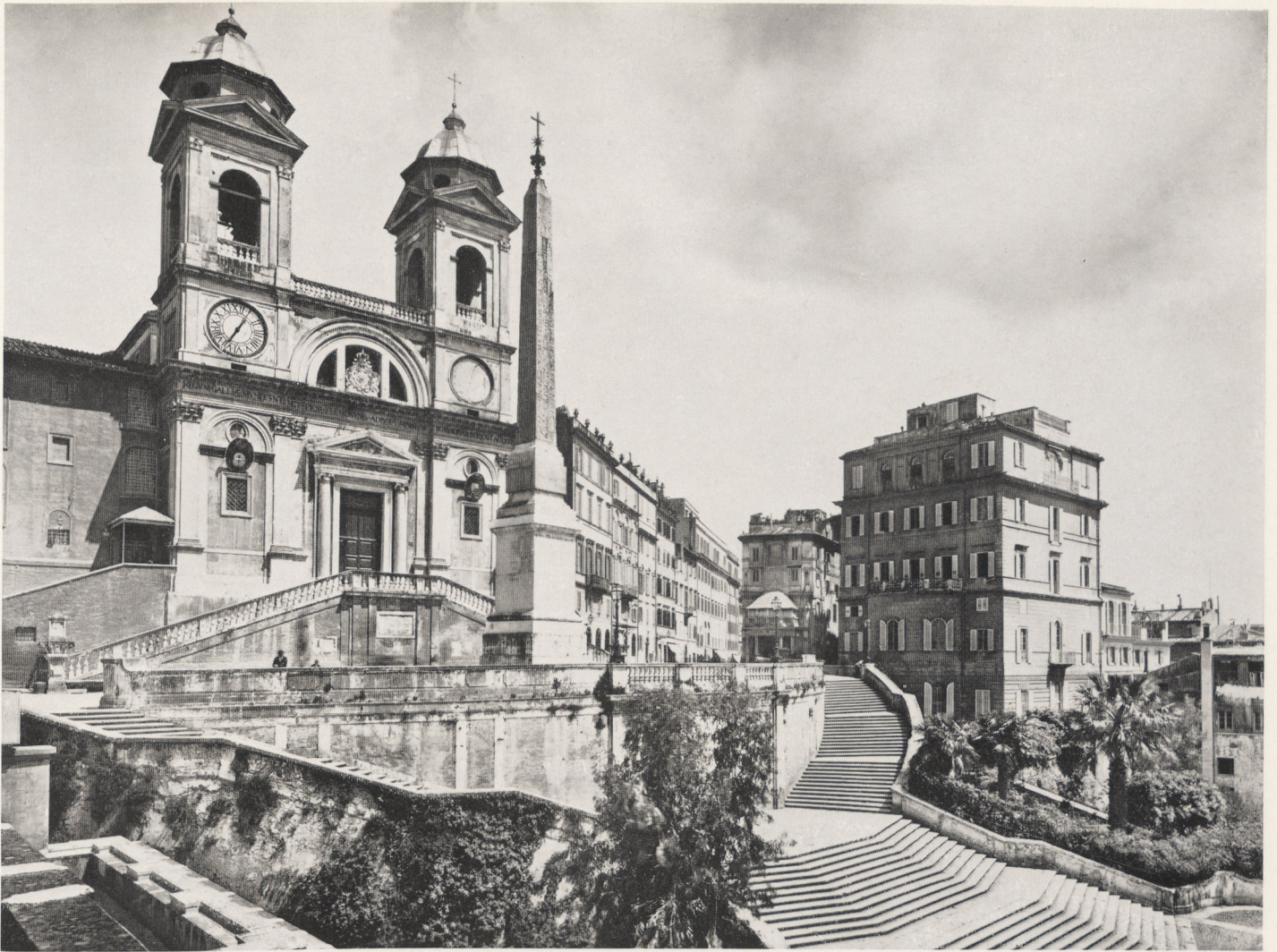
14. Kirche, Palazzo Zuccari und oberster Treppenlauf
