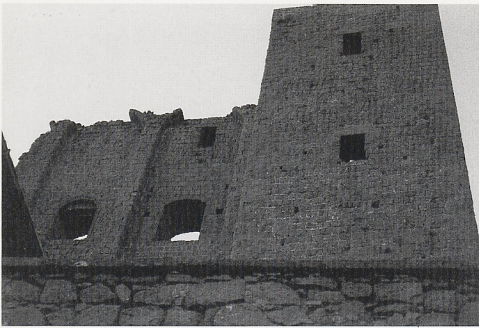
21. Montefiascone, Papstpalast, Südwest-Trakt
