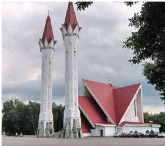
Il. 8. Ufa, Republika Baszkortostan. Meczet „Lala-Tulipan” zbudowany w latach 1989–1998. Architekt: W. Devletszyn. Zdjęcie z archiwum moskiewskiego czasopisma „Sobranije”
