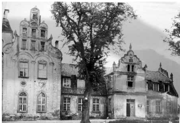
Il. 16. Przysiek, pałac. Zdjęcie z 1959 r. ukazujące fasadę niszczonego obiektu [źródło: B. Sadurska, Przysiek, woj. toruńskie. Zespół przemysłowo-dworski. Dokumentacja historyczno-architektoniczna wykonana na zlecenie Kombinat PGR w Przysieku. Tom I. Zdjęcia fotograficzne, Toruń 1976, fot. 31]
