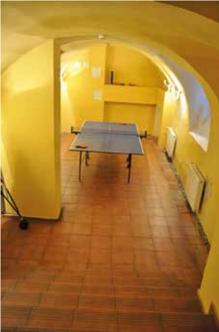
Il. 3. Przysiek, pałac. Pomieszczenie piwniczne pod południowo-zachodnią częścią pierwotnego skrzydła – relikw najstarszej fazy budowlanej. Widoczne sklepienie kolebkowe [autor: Grzegorz Grąbczewski, 2018]
