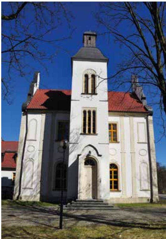
Il. 10. Przysiek, pałac. Widok elewacji południowej skrzydła z salą balową. Widoczny ryzalit wieży [autor: Grzegorz Grąbczewski, 2018]
