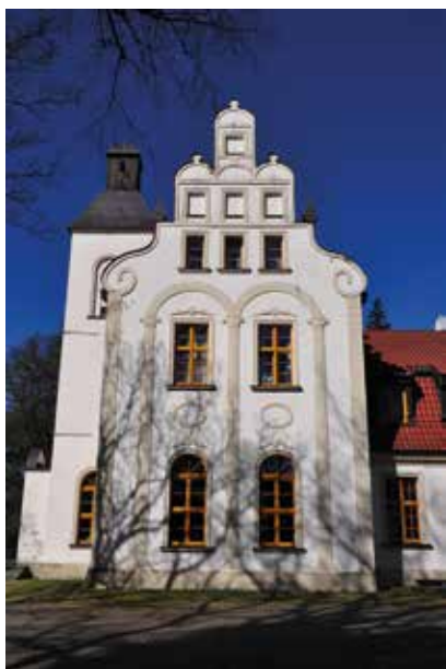
Il. 14. Przysiek, pałac. Dekoracja architektoniczna na wschodniej elewacji skrzydła południowego [autor: Grzegorz Grąbczewski, 2018]
