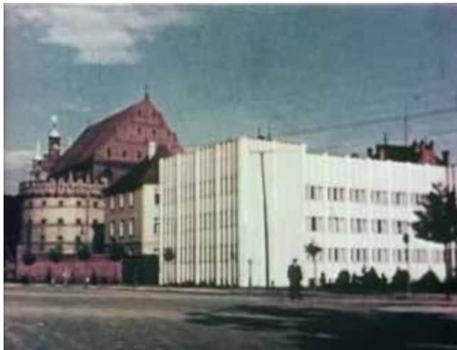
Il. 6. Gmach Starostwa Krajowego Pomorskiego w Toruniu, ob. Collegium Minus UMK, ul. Fosa Staromiejska 1a. Elewacja północna i fragment elewacji zachodniej w roku 1938.
