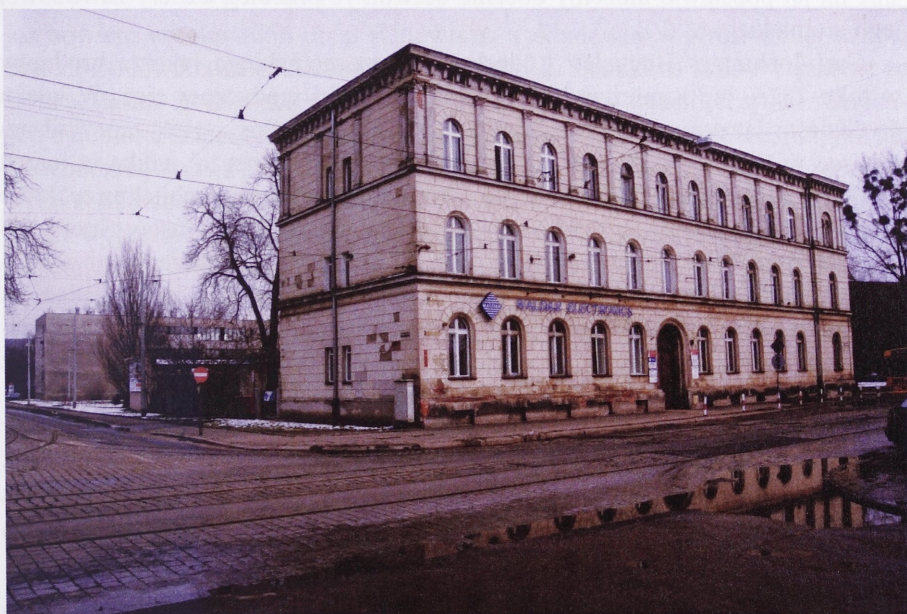
Il. 2. Wrocław, budynek Intendentury Wojskowej, proj. F. A. Stüler, 1844
