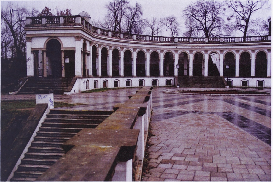
Il. 4. Wrocław, kolumnada na Wzgórzu Liebicha (obecnie Partyzantów), proj. C. Schmidt, 1869
