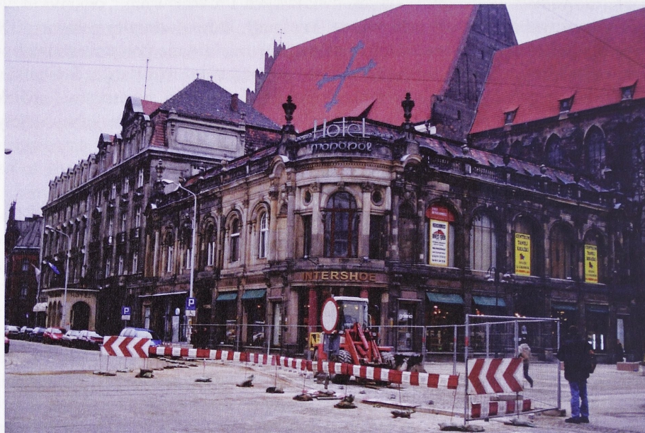
Il. 8. Wrocław, dawny dom handlowy Monopol, proj. Grosser & Brost, 1891–1892
