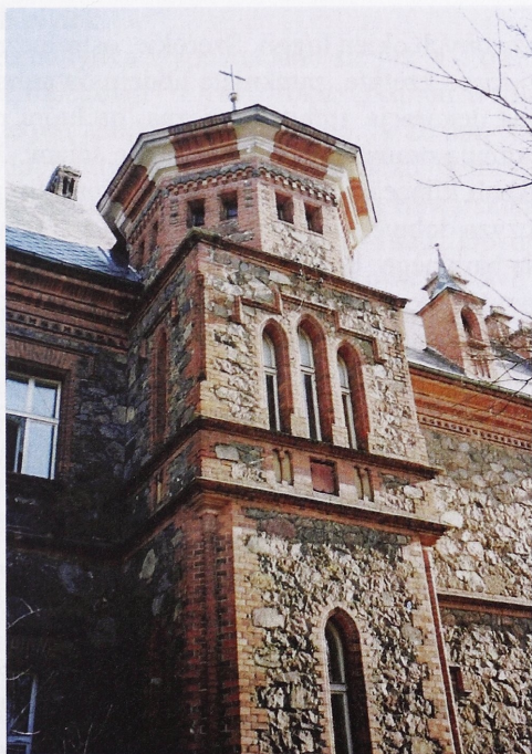
Il. 5. Szpital pw. św. Doroty w Żaganiu. Elewacja zachodnia, ryzalit. Fot. autorka
