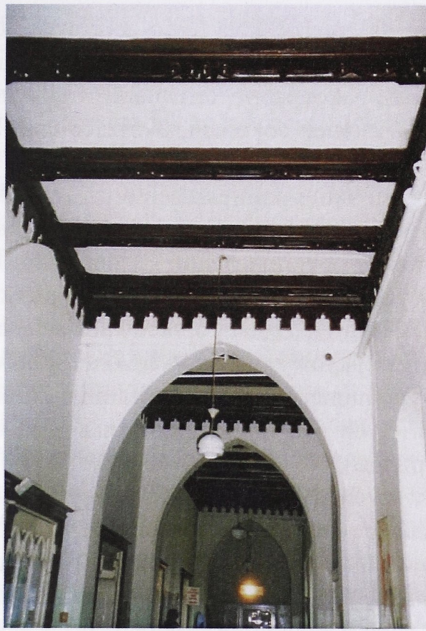
Il. 9. Szpital pw. św. Doroty w Żaganiu. Korytarz piętra. Fot. autorka
