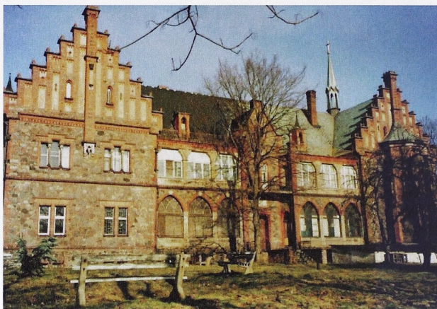
Il. 6. Szpital pw. św. Doroty w Żaganiu. Elewacja południowa. Fot. autorka
