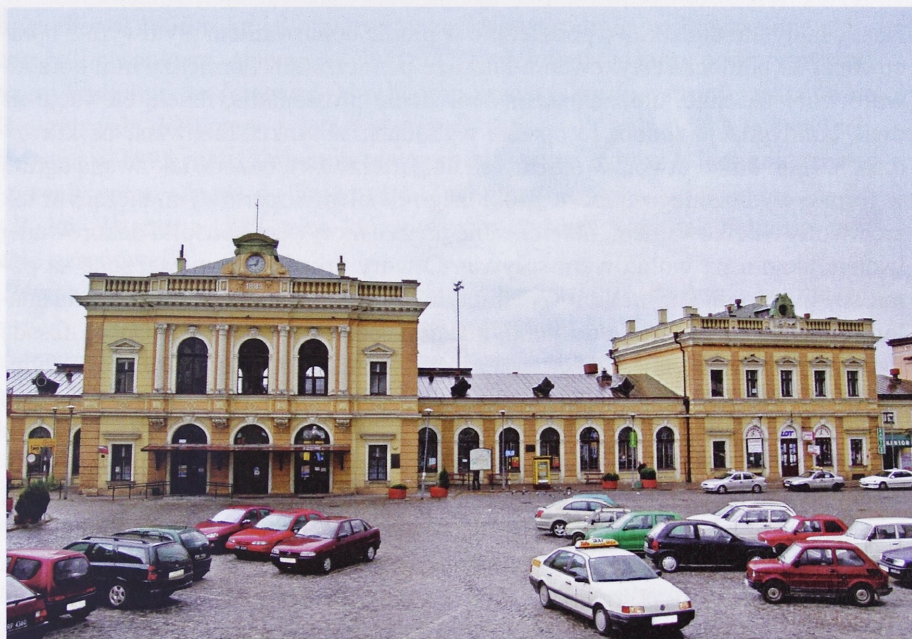
Il. 4. Przemyśl, drugi dworzec kolejowy, widok od strony podjazdu, stan z 2007 r. Fot. autorka
