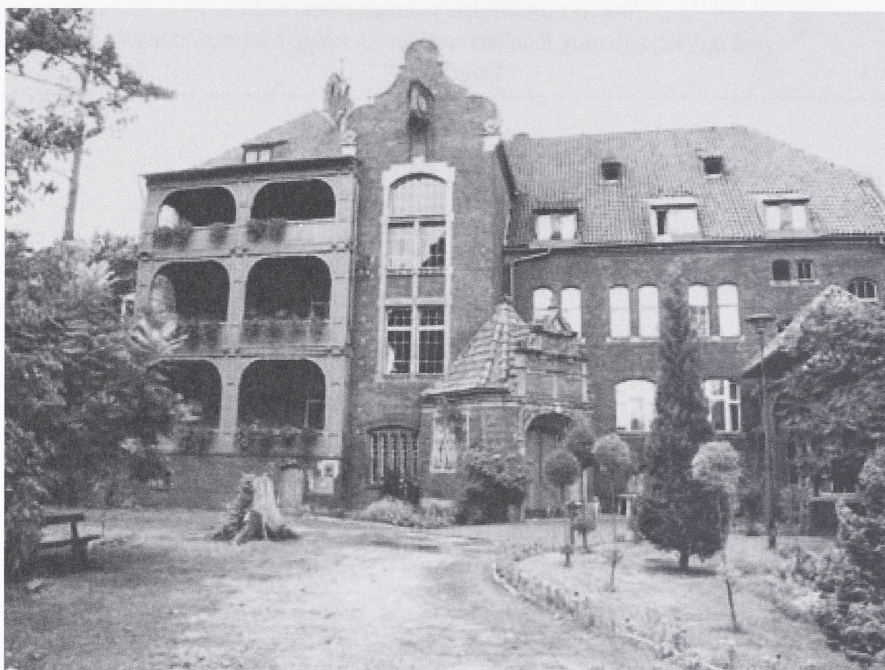
II.1. Budynek główny dawnego sanatorium w Trzebiechowie
