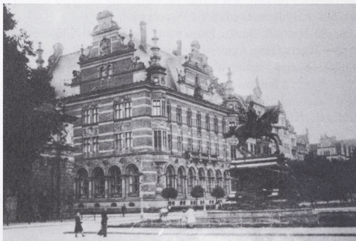
Il. 2. Gdańsk – dawny budynek Oddziału Głównego Banku Rzeszy ul. Okopowa 1, stan z ok. 1920 r., zbiory PAN
