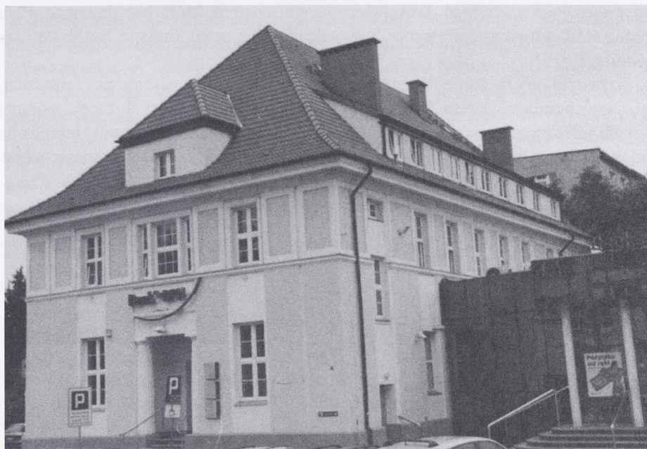
Il. 5. Kołobrzeg – dawny budynek Oddziału Głównego Banku Rzeszy – stan obecny. Fot. autorka
