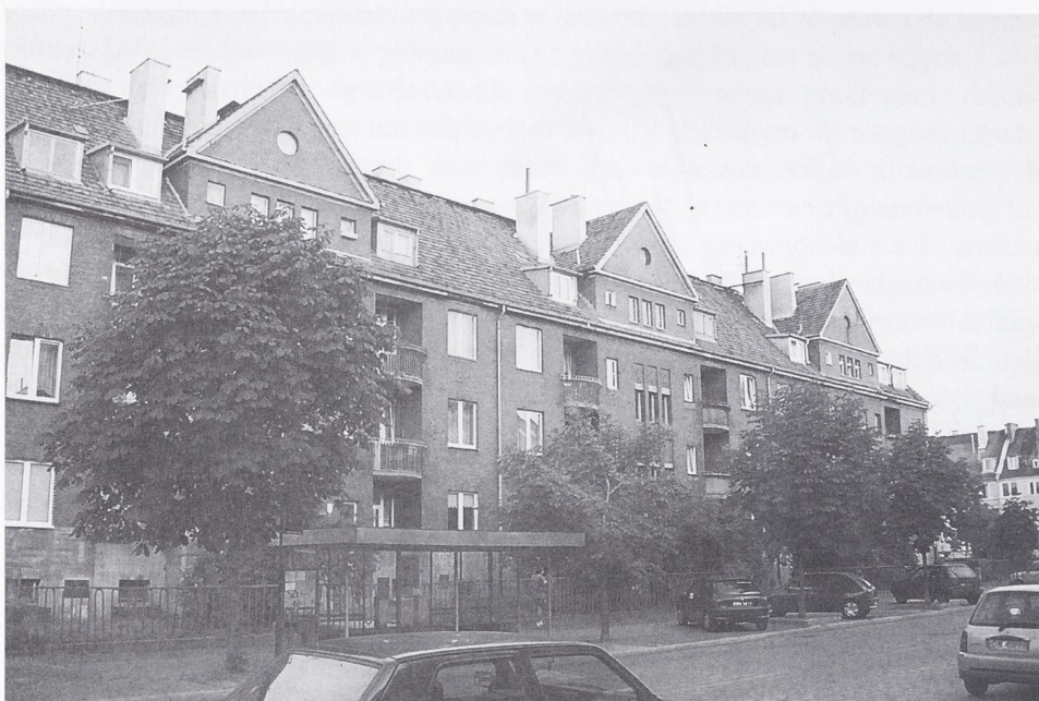
Il. 4. Wrocław, budynek Fundacji J. Gotthelfa, elewacja frontowa, fot. 2005
