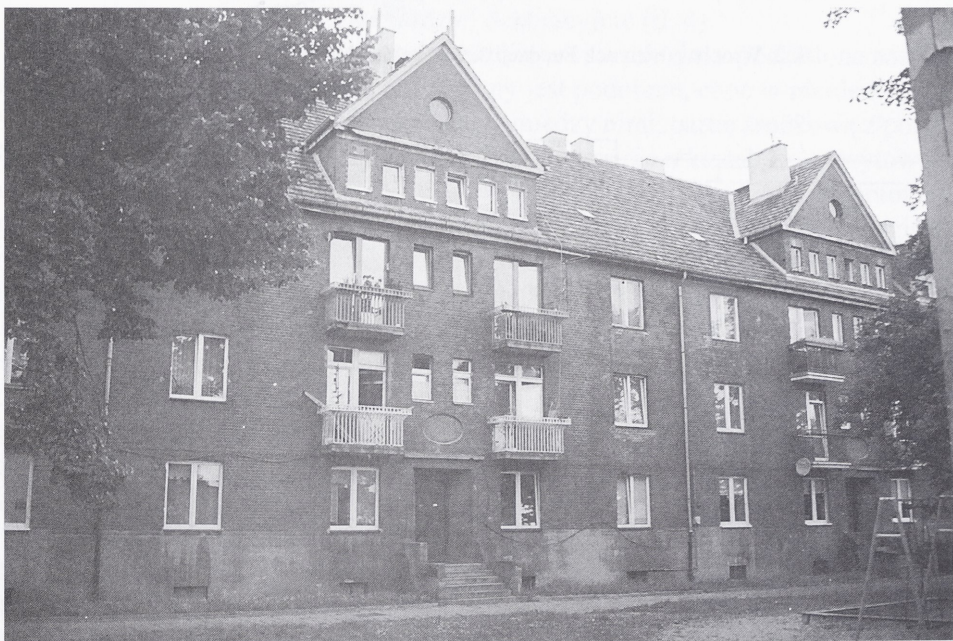
Il. 5. Wrocław, budynek Fundacji J. Gotthelfa, elewacja tylna, fot. 2005
