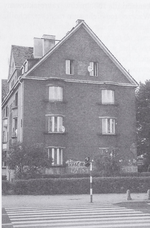
Il. 6. Wrocław, budynek Fundacji J. Gotthelfa, elewacja południowa zwrócona w stronę ul. Hallera, fot. 2005
