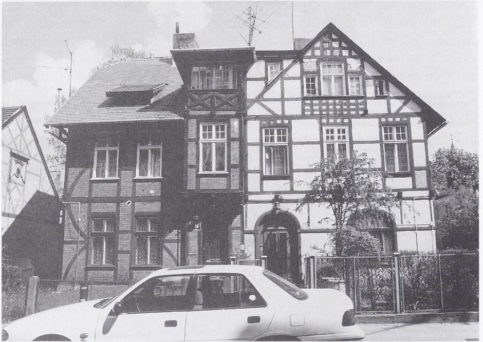
Ryc. 10. Toruń, ul. Konopnickiej 12 i 14. Budynek szkieletowe wzniesione w 1899 r. Fot. P. Grajek
