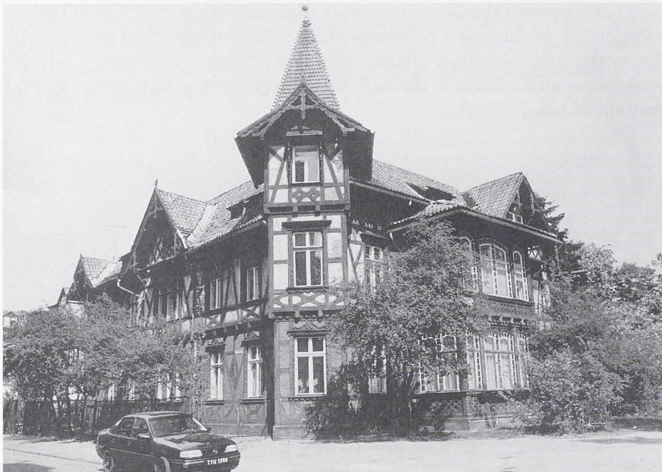
Ryc. 8. Toruń, ul. Bydgoska 40. Budynek szkieletowy wzniesiony w 1895 r. Fot. P. Grajek
