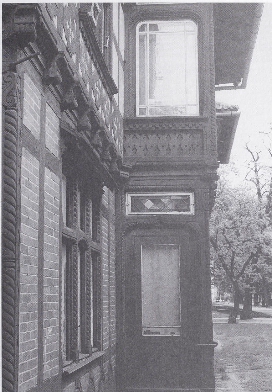
Ryc. 5. Toruń, ul. Bydgoska 34/36. Fragment elewacji południowej. Fot. P. Grajek
