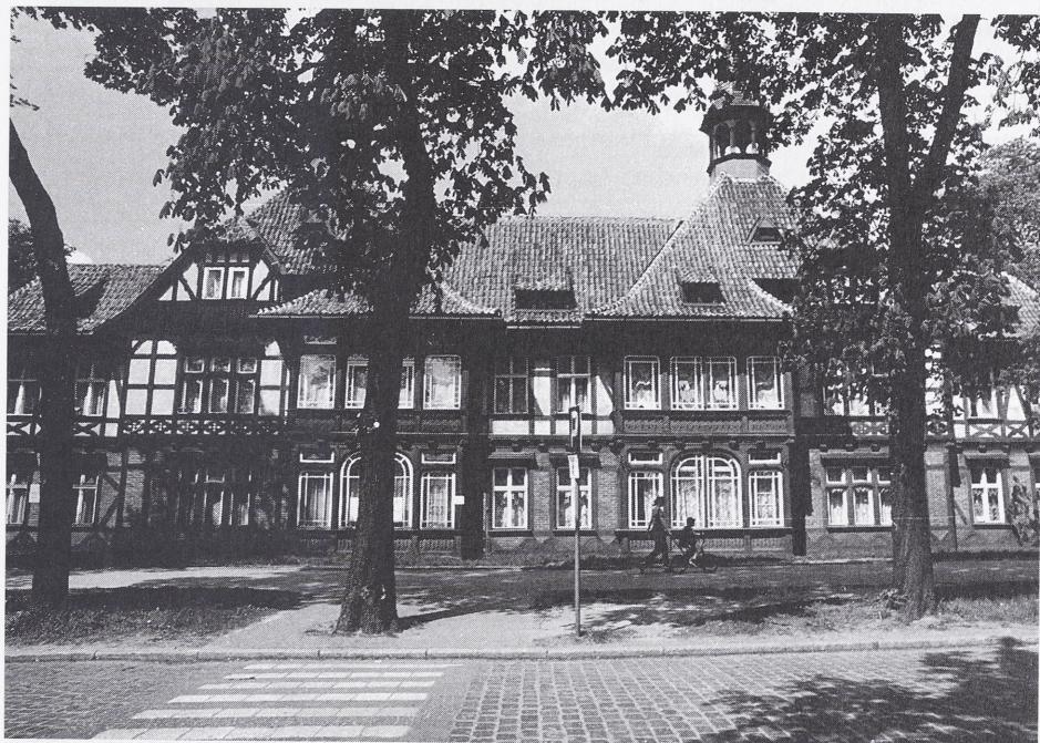
Ryc. 3. Toruń, ul. Bydgoska 34/36. Budynek szkieletowy wzniesiony w 1895 r.
