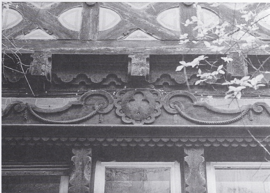
Ryc. 9. Toruń, ul. Bydgoska 40. Fragment dekoracji elewacji wschodniej. Rodzaj zwieńczenia okna oraz sposób kształtowania podwaliny pierwszego piętra. Fot. P. Grajek
