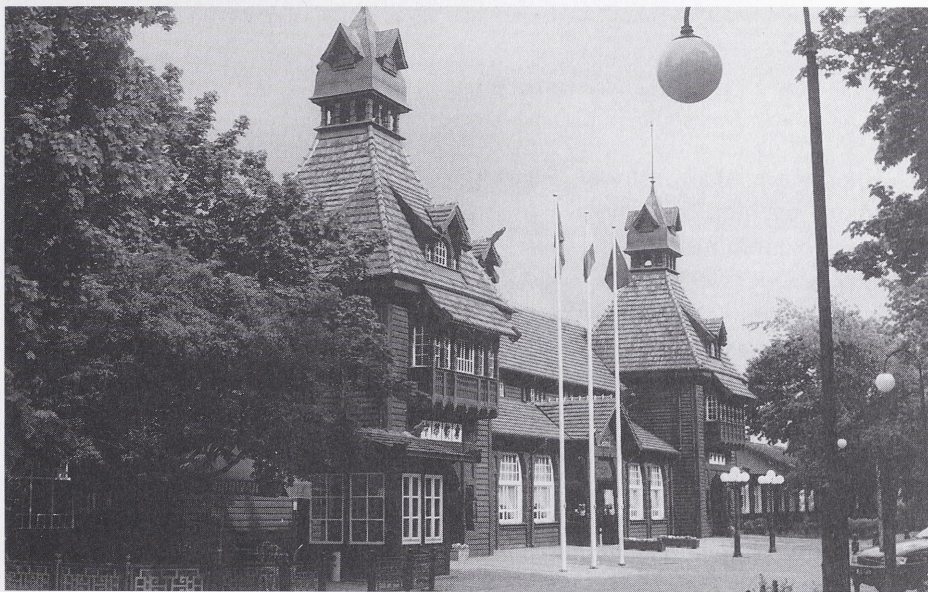
Ryc. 8. Obecny stan Łazienek Południowych
