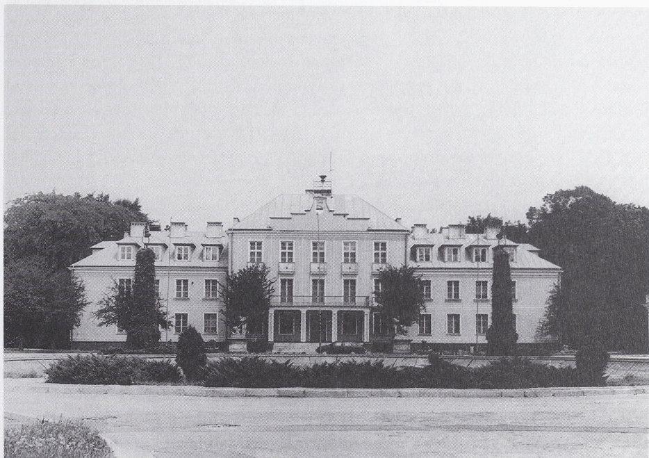
Ryc. 15. Budynek pałacu po odbudowie, widok od strony dziedzińca. Stan współczesny Fot. A. Jelonkiewicz-Chęć
