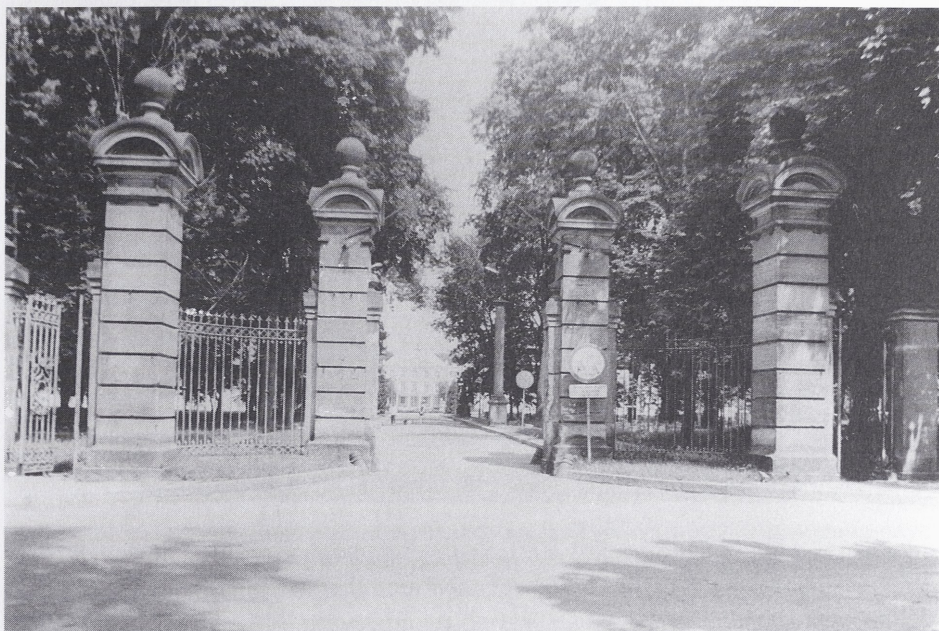
Ryc. 11. Brama wjazdowa do pałacu. Stan współczesny. Fot. A. Jelonkiewicz-Chęć
