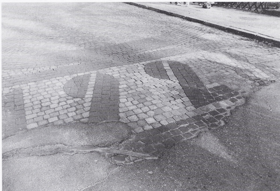
Ryc. 18. Częściowo zachowana, ułożona z bruku data rozpoczęcia budowy CIWF, stan luty 1998. Fot. T. Śleboda
