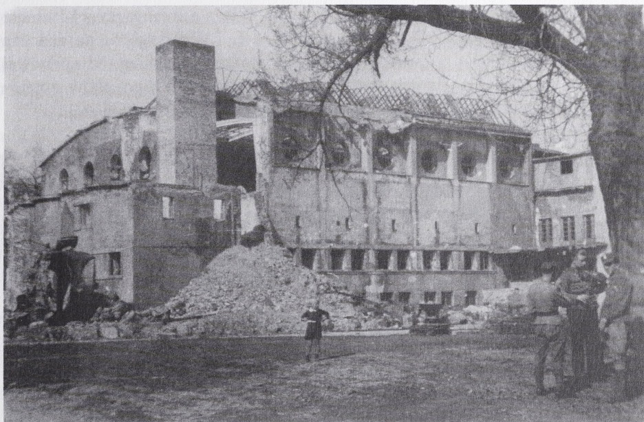
Ryc. 15. Widok krytej pływalni, stan z 1945 roku (wg oryg. Archiwum AWF, fot. W. Zawistowska)
