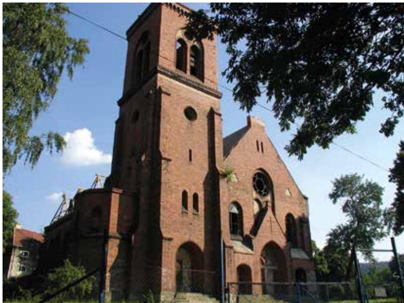
Il. 13. Wałbrzych. Cerkiew prawosławna Wszystkich Świętych, d. kościół ewangelicki. Widok zewnętrzny kościoła od strony zachodniej w trakcie remontu (fot. J. Uściłowicz, 2003 r.)
