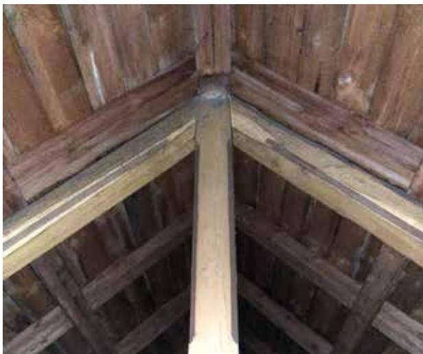
Il. 10. Mrągowo, dawna synagoga, obecnie cerkiew prawosławna, fragment elementów konstrukcyjnych więźby dachowej nad pomieszczeniem liturgicznym z widocznym malowaniem i fazowaniem krawędzi belek (fot. Bartosz Hellis, 2021)
