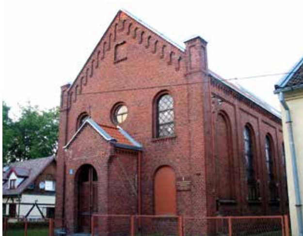
Il. 5. Mrągowo, dawna synagoga, obecnie cerkiew prawosławna. Widok od strony południowo-zachodniej (fot. Bartosz Hellis, 2007)
