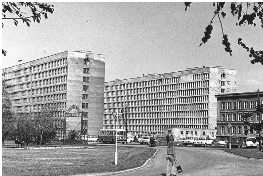
Il. 8. Wydział Budowy Maszyn, I Wydział Elektryczny Politechniki Poznańskiej przy ul. Piotrowo, proj. Lech Sternal (źródło: zbiory Biblioteki Raczyńskich)
