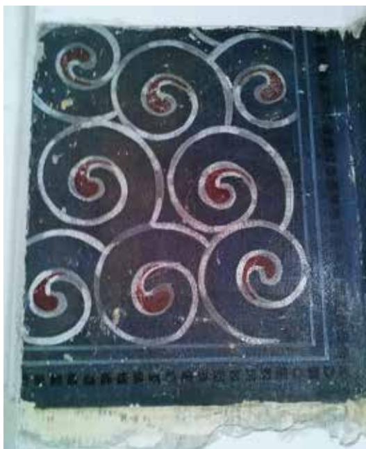
Il. 7. Budynek VI Liceum Ogólnokształcącego w Bydgoszczy przy ul. Staszica 4. Odkrywka polichromii ścian apsydy (fot. B. Piaskowska, 2017 r.)
