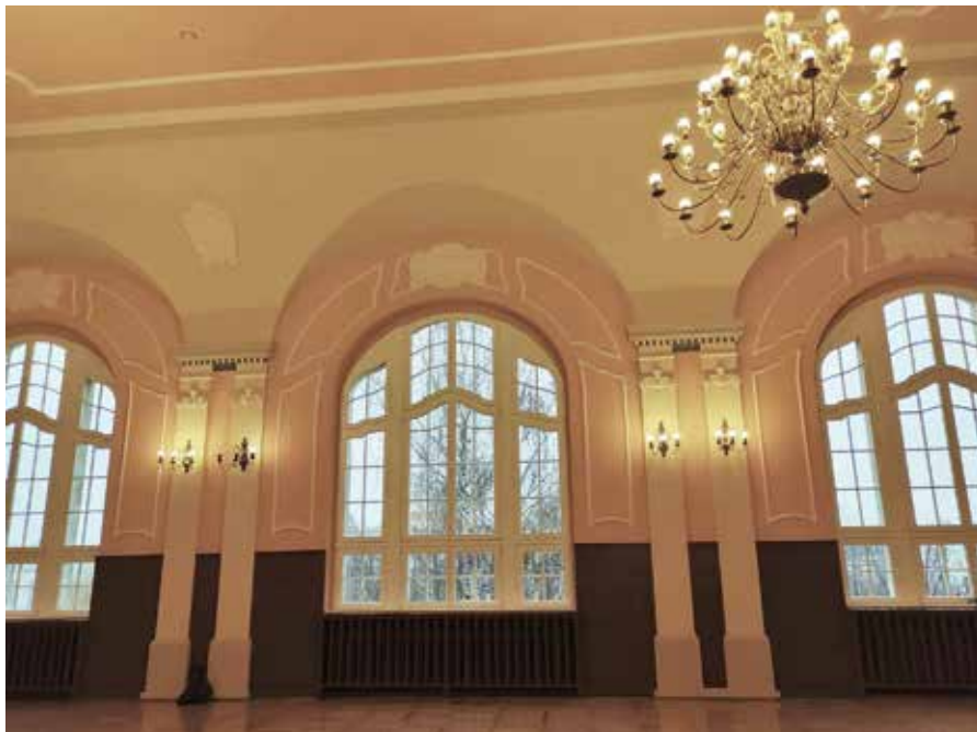
Il. 9. Budynek VI Liceum Ogólnokształcącego w Bydgoszczy przy ul. Staszica 4. Widok auli po pracach konserwatorsko-remontowych, widok ściany południowej (fot. B. Piaskowska, 2021 r.)
