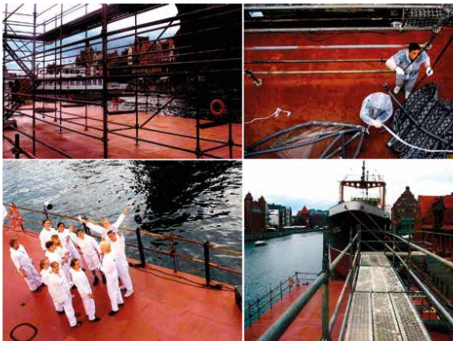
Il. 13. Montaż zdjęć dokumentujących przyspawanie rusztowań do podłoża barki oraz pracę zespołu nad scenografią Teatru na Barce. Miasta Możliwego , 2011 (fot. Katarzyna Zawistowska)
