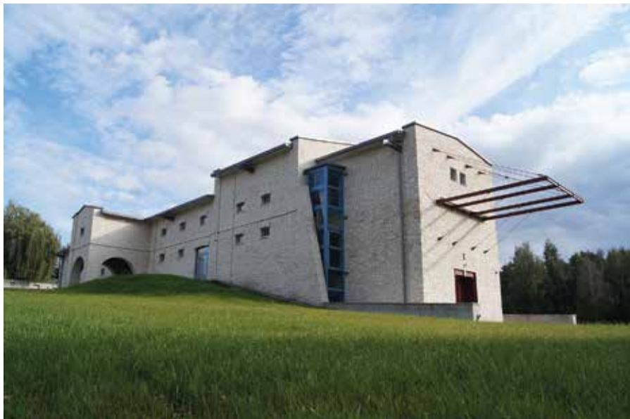
Il. 36. Nowa Scena Rzymska Akademii Praktyk Teatralnych Gardzienice. Widok od strony północno-zachodniej. Proj. J. Uścińowicz (fot. autor, 2013 r.)
