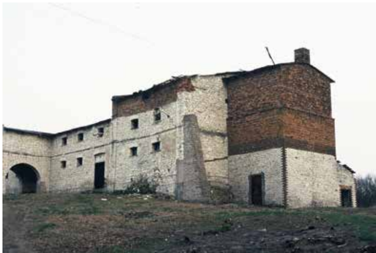
Il. 7. Gardzienice. Spichlerz w stanie zrujnowanym, przed restauracją. Widok od strony północno-zachodniej, z wartowni (fot. J. Uścińowicz, 2004 r.)
