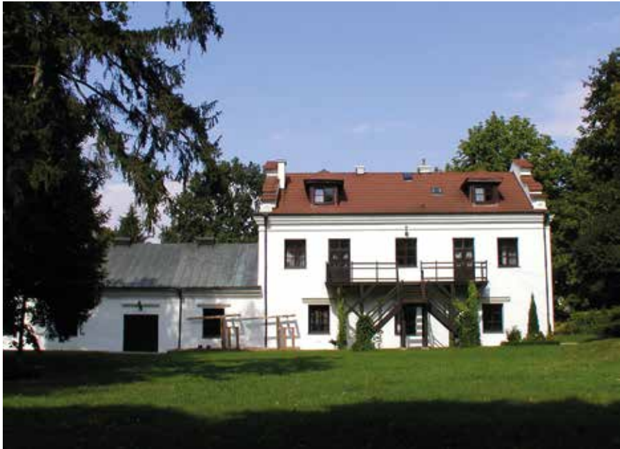
Il. 13. Gardzienice. Oficyna dworska (południowa) z pocz. XVII w. Widok od strony południowej parku, z parkowej polany (fot. J. Uścińowicz, 2005 r.)
