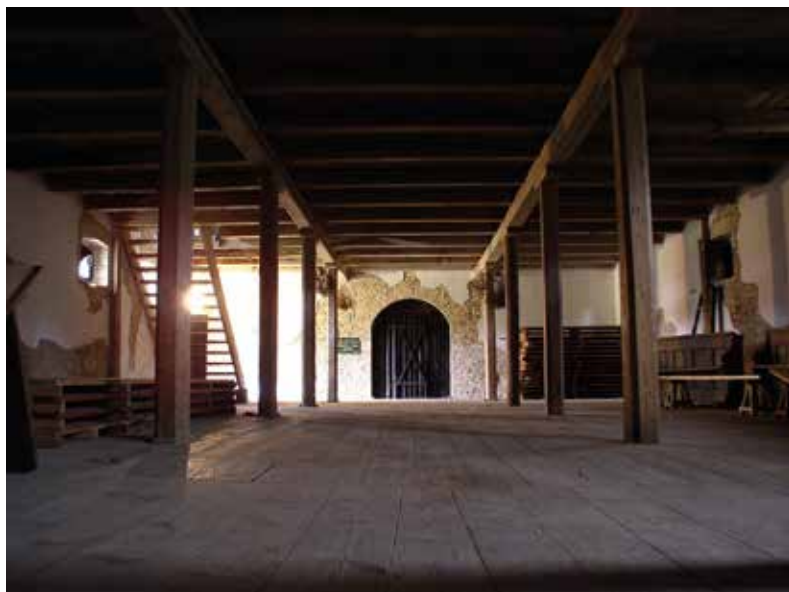
Il. 8. Gardzienice. Wnętrze spichlerza przed restauracją. Widok parteru od strony zachodniej (fot. P. Lipiński, 2004 r.)
