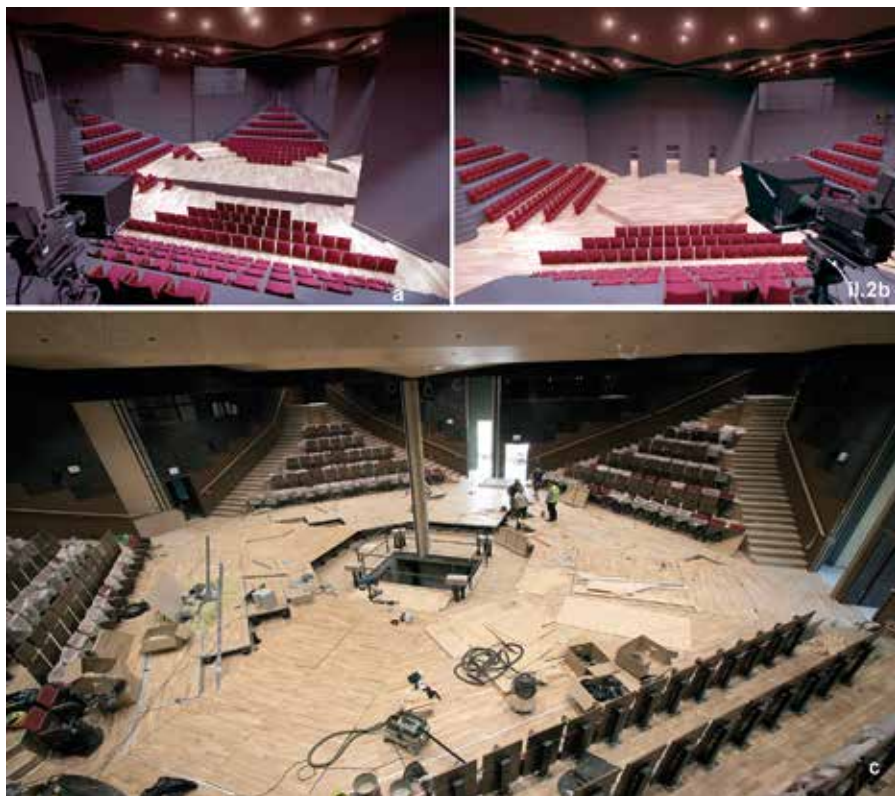
Il. 2a. Scena ulicowa – wizualizacja; b. Scena quasi klasyczna – wizualizacja; c. Wykonanie i jednoczesny montaż praktykabl (fot. Piotr Obracaj, 2022)
