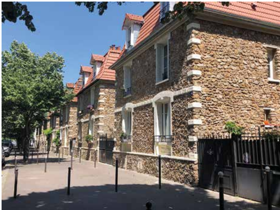
Il 8. Paryż, rue de Chablis, zabudowa pierzejowa domów z okrzesków, fot. C. Luscinski, 2023
