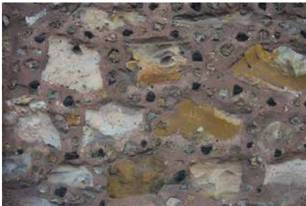
Il. 6. Fragment lica muru z okrzesków ze spoiną uzupełnianą drobnymi kamieniami i rozkruszoną cegłą http://sosmaisons95.e-monsite.com/pages/histoire-de-la-meuliere.html [dostęp: 23.06.2023]
