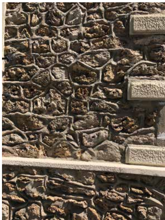
Il. 7. Fragment lica muru z okrzesków z wydatną wapienną spoiną, fot. C. Luscinski, 2023
