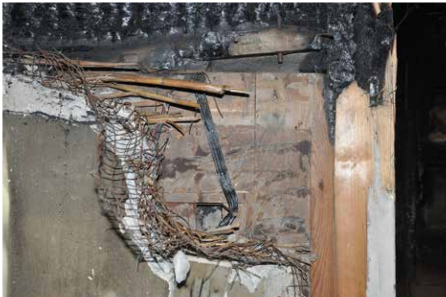
Il. 6. Wrocław, dawna willa Waltera Hentschela na ul. Chopina 25 z 1924, ściana z bali z wewnętrzną okładziną z taflí o konstrukcji ramowo-płycinowej (fot. U. Schaaf, 2022)
