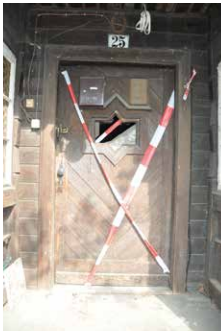
Il. 11. Wrocław, dawna willa Waltera Hentschela na ul. Chopina 25 z 1924, drzwi wewnętrzne, czteroskrzydłowe, ramowo-płycinowe ze szkolonymi prześwitami (fot. U. Schaaf, 2022)
