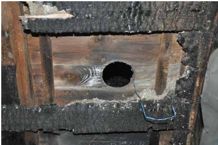
Il. 7. Wrocław, dawna willa Waltera Hentschela na ul. Chopina 25 z 1924, strop ze ślepym pułapem (fot. U. Schaaf, 2022)
