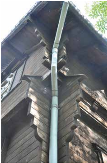
Il. 4. Wrocław, dawna willa Waltera Hentschela na ul. Chopina 25 z 1924, połączenie bali na obłap w narożniku z ostatkami (fot. U. Schaaf, 2022)
