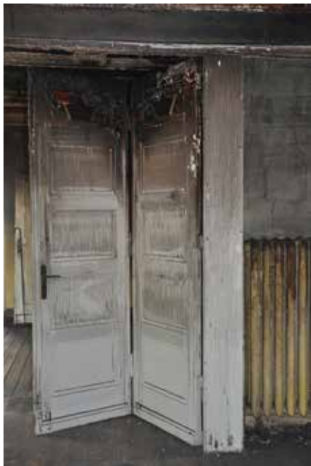
Il. 11. Wrocław, dawna willa Waltera Hentschela na ul. Chopina 25 z 1924, drzwi wewnętrzne, czteroskrzydłowe, ramowo-płycinowe ze szkolonymi prześwitami (fot. U. Schaaf, 2022)
