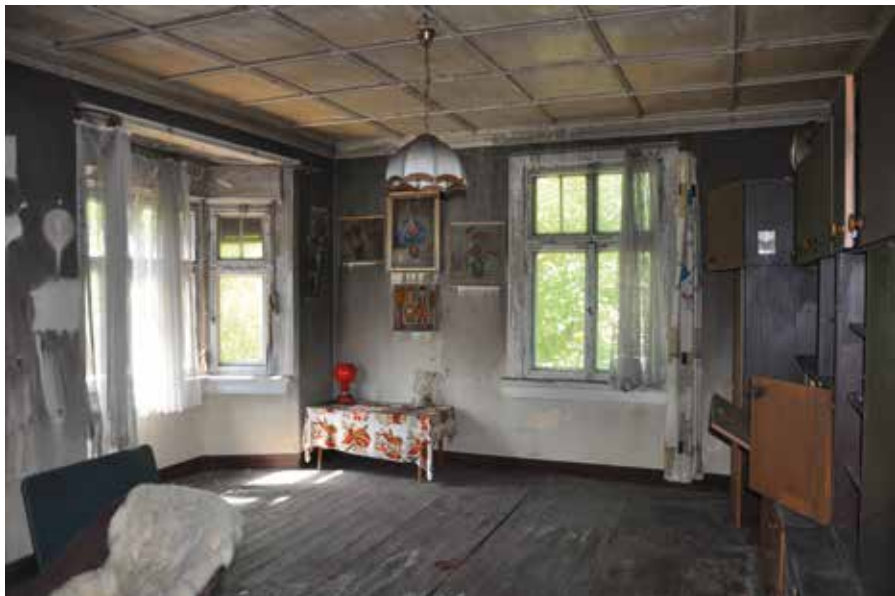
Il. 8. Wrocław, dawna willa Waltera Hentschela na ul. Chopina 25 z 1924, strop z dolnym pułapem płytowym listowo-kasetonowym (fot. U. Schaaf, 2022)
