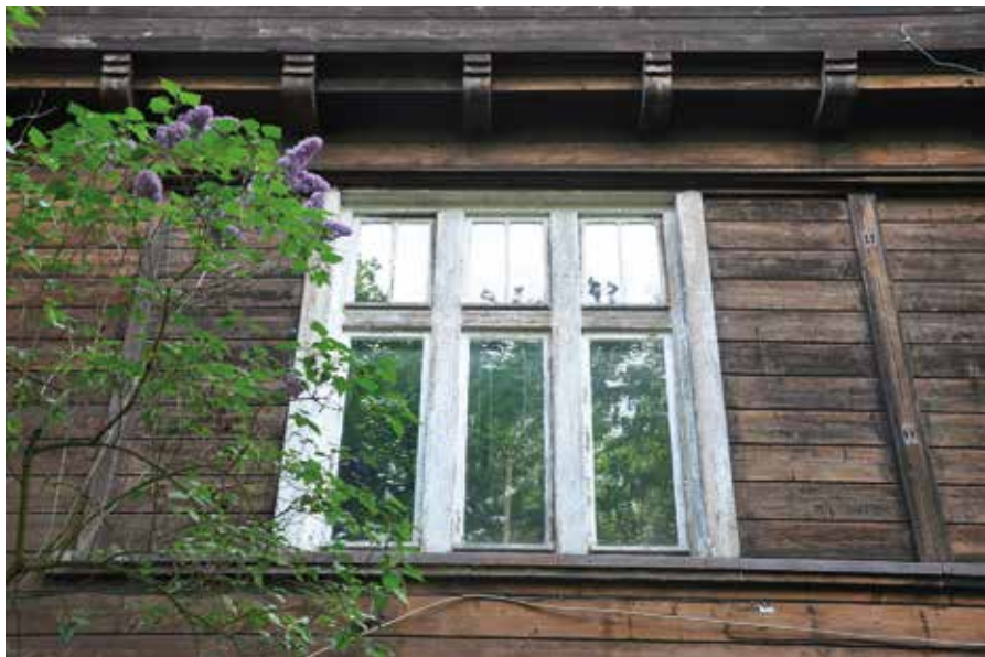
Il. 13. Wrocław, dawna willa Waltera Hentschela na ul. Chopina 25 z 1924, okno zespolone, dwupoziomowe, trójdzielne (fot. U. Schaaf, 2022)
