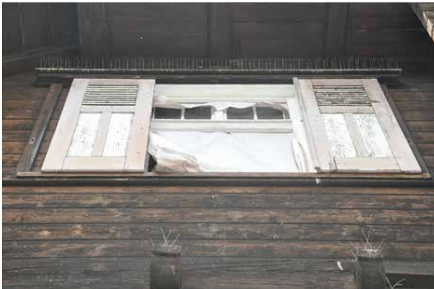
Il. 15. Wrocław, dawna willa Waltera Hentschela na ul. Chopina 25 z 1924, okiennice o konstrukcji ramowo-płycinowej z górnymi żaluzjami (fot. U. Schaaf, 2022)
