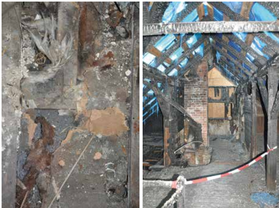
II. 9. Wrocław, dawna willa Waltera Hentschela na ul. Chopina 25 z 1924, strop z dodatkową izolacją dźwiękową pomiędzy belkami i powalę (fot. U. Schaaf, 2022)
